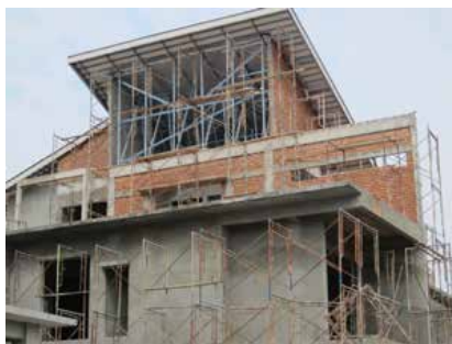
従来のレンガ積みの住宅を建設する様子
