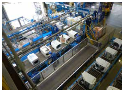
PETECに新設された洗濯機解体ライン
